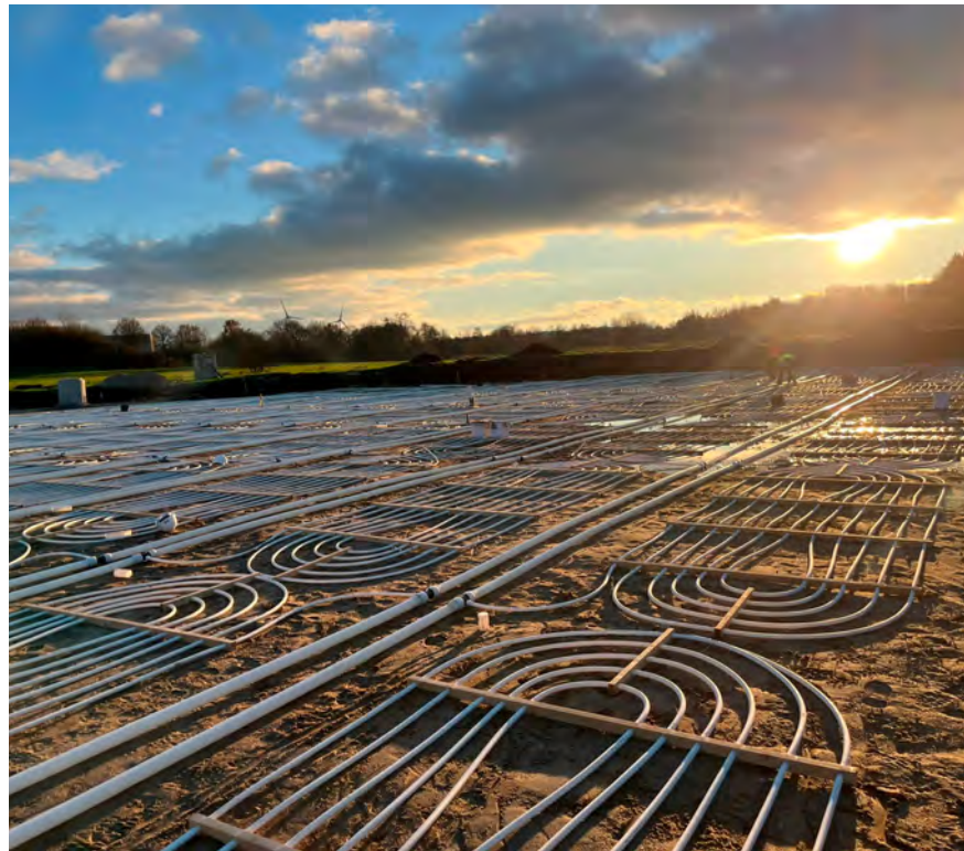
Verlegung einlagiger Kollektoren Bildquelle: Steinhäuser GmbH & Co. KG
