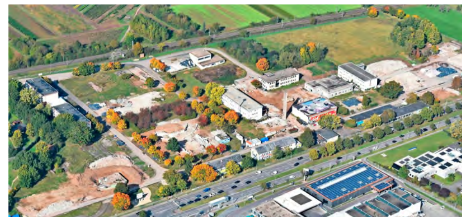
Luftaufnahme des Baugebietes. Bildquelle: Portaflyg Föhren
