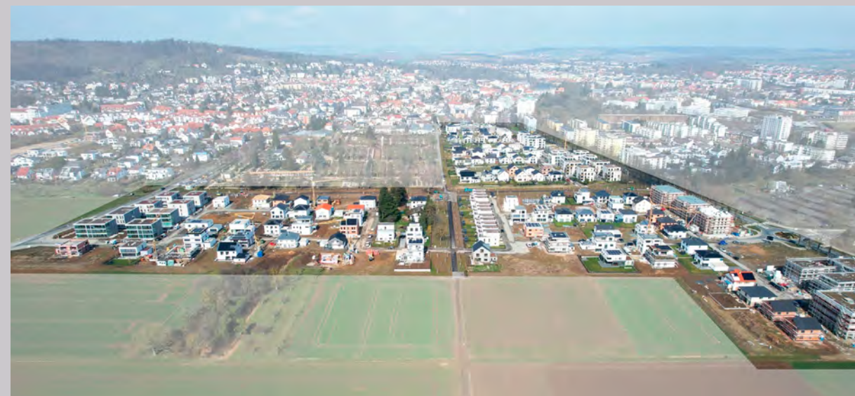
Referenzprojekt für Kalte Nahwärme im großen Stil: Das Neubaugebiet Bad Nauheim Süd. Bildquelle: Institut für Energie und Gebäude (ieg) der Technischen Hochschule Nürnberg
