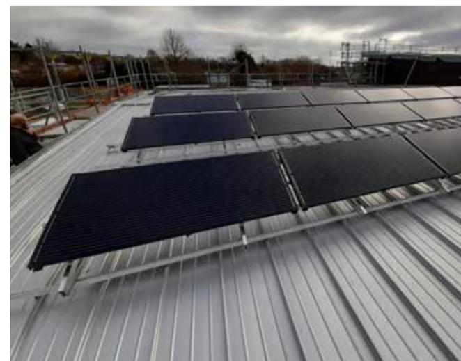
Abbildung 2: 20x PVT-Module (Modulfläche 2 m<sup>2</sup>). Bildquelle: Stadtwerke Schleswig.
