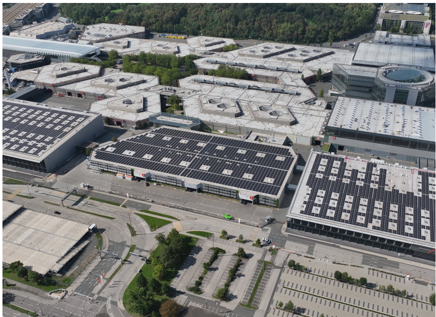
Übersicht der Hallen der NürnbergMesse GmbH mit Aufdach-PV-Anlagen. Foto: wirdenkenlokal
