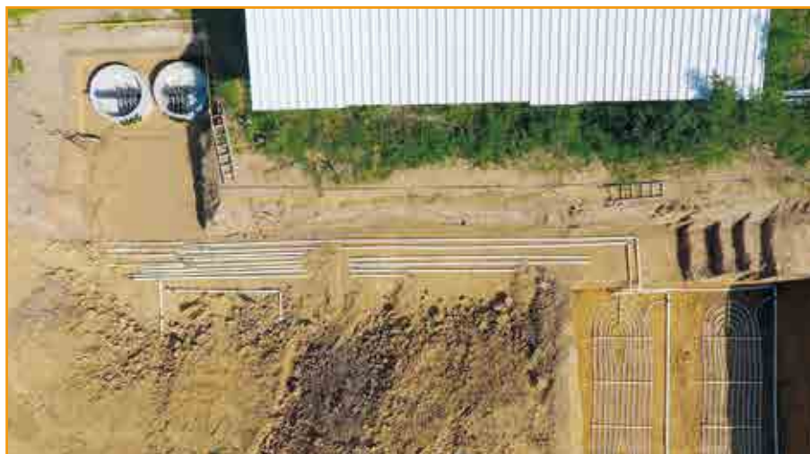
Verbindung der einzelnen Stränge auf den dazugehörigen Verteilerschacht.
