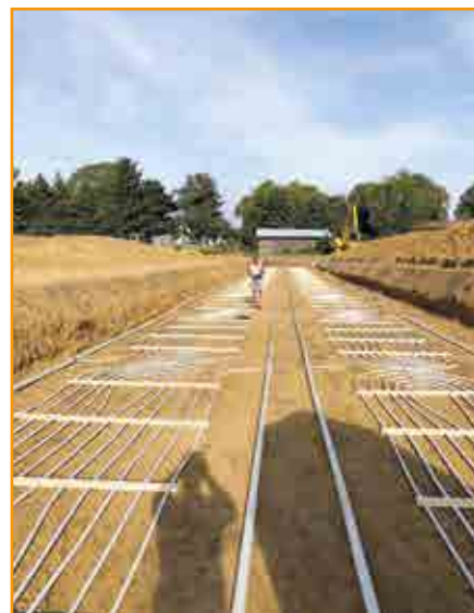
GPS-Einmessung des Energiefeldes.
