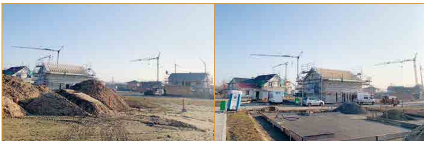
Die ersten Häuser stehen schon im Sommeracher Neubaugebiet, hier wurde letztes Jahr die Erdwärme erschlossen. Bevor ein Haus errichtet wird, werden alle Versorgungsleitungen, inkl. Erdwärme ins Haus eingeführt.
