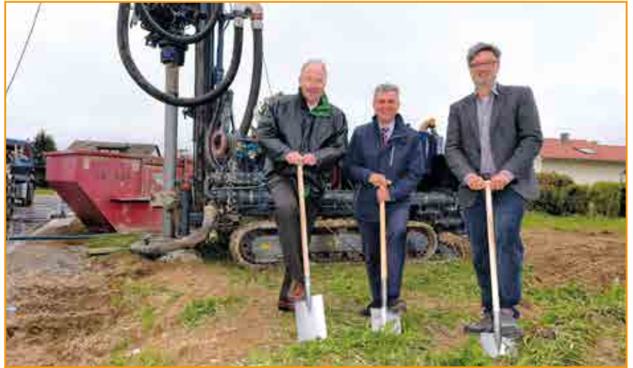
Spatenstich zum Nahwärmenetz. Über das tolle Projekt freuen sich (v.l.) LEW-Vorstandsmitglied Norbert Schürmann, Bad Grönenbachs Bürgermeister Bernhard Kerler und Christoph Knepel, Geschäftsführer baugrund süd GmbH.
