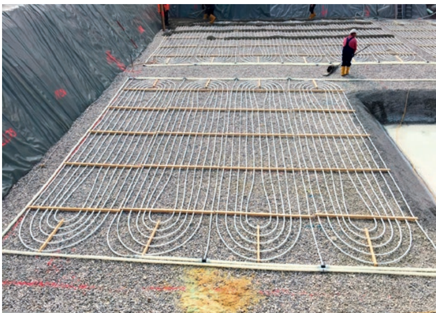
Abb. 1 – Erdwärmekollektoren unter einem Mischgebäude (Supermarkt, Büro- und Wohnräume) zur Versorgung mit Wärme und Kälte im Rahmen des Forschungsvorhabens „Netzneutrales Energie-Quartier“ im Herzen von Geretsried
